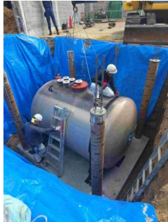
(給油所 地下タンク更新)
