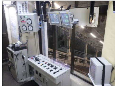
制御装置更新（自動運転化）工事
