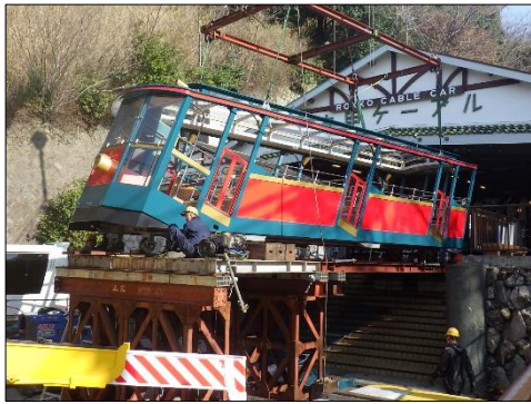
車両リニューアル工事
