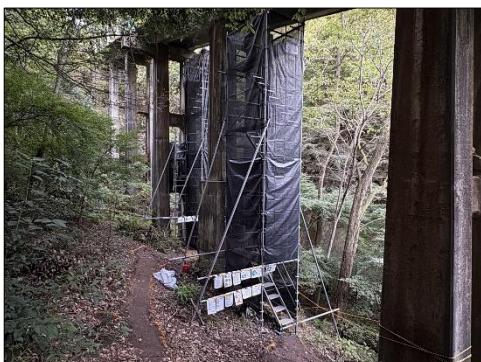
橋りょう点検補修
