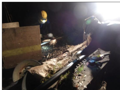
レール継目補修
