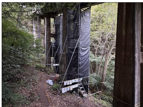
橋りょう点検補修
