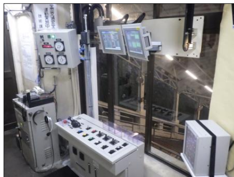
制御装置更新（自動運転化）工事
