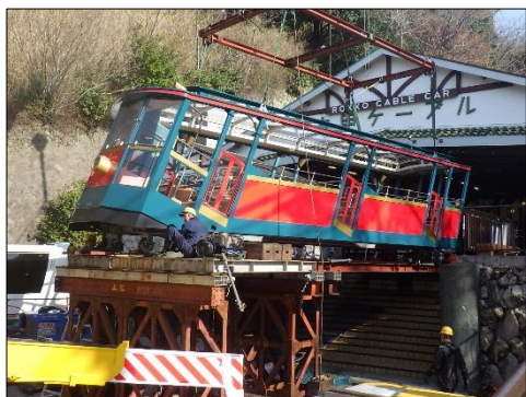
車両リニューアル工事
