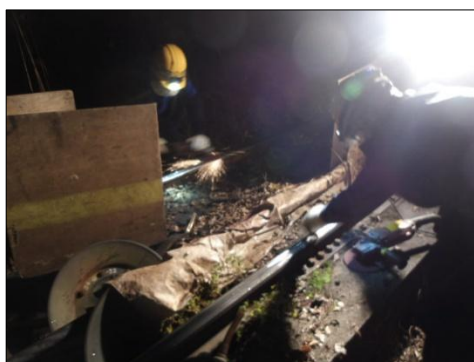
レール継目補修
