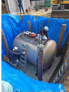
(給油所 地下タンク更新)
